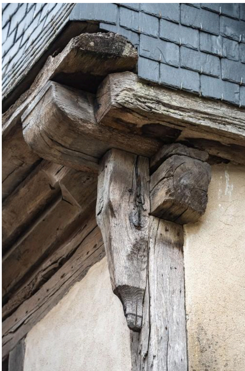
Détail de l'assemblage entre le poteau cornier, la sablière de plancher, l'entretoise, la sablière de chambrée et la solive d'ébordante.
