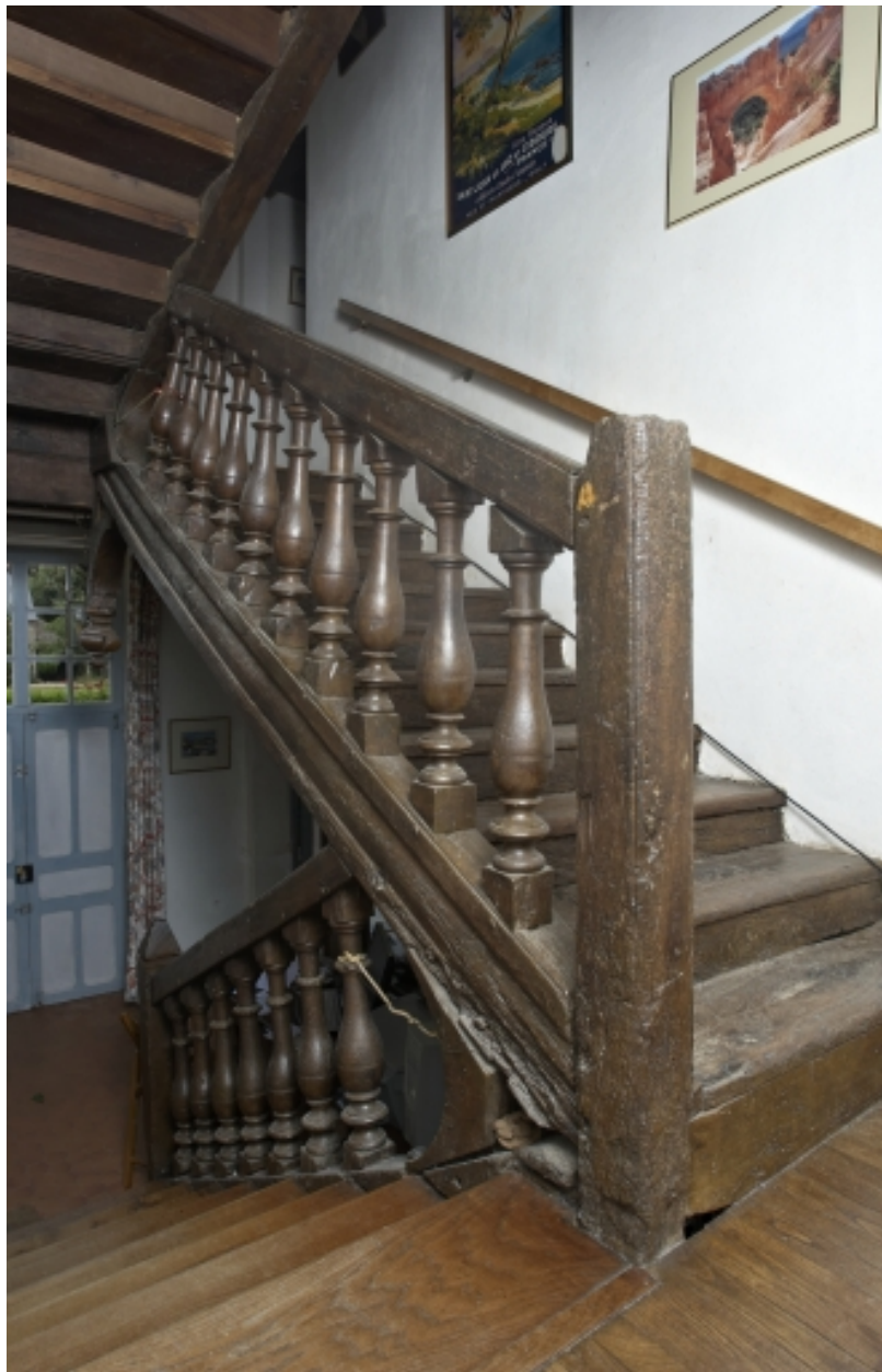
Escalier dans oeuvre en charpente
