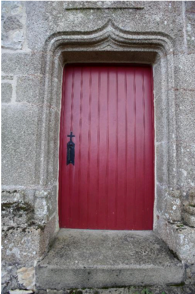
Détail de la porte du transept nord
