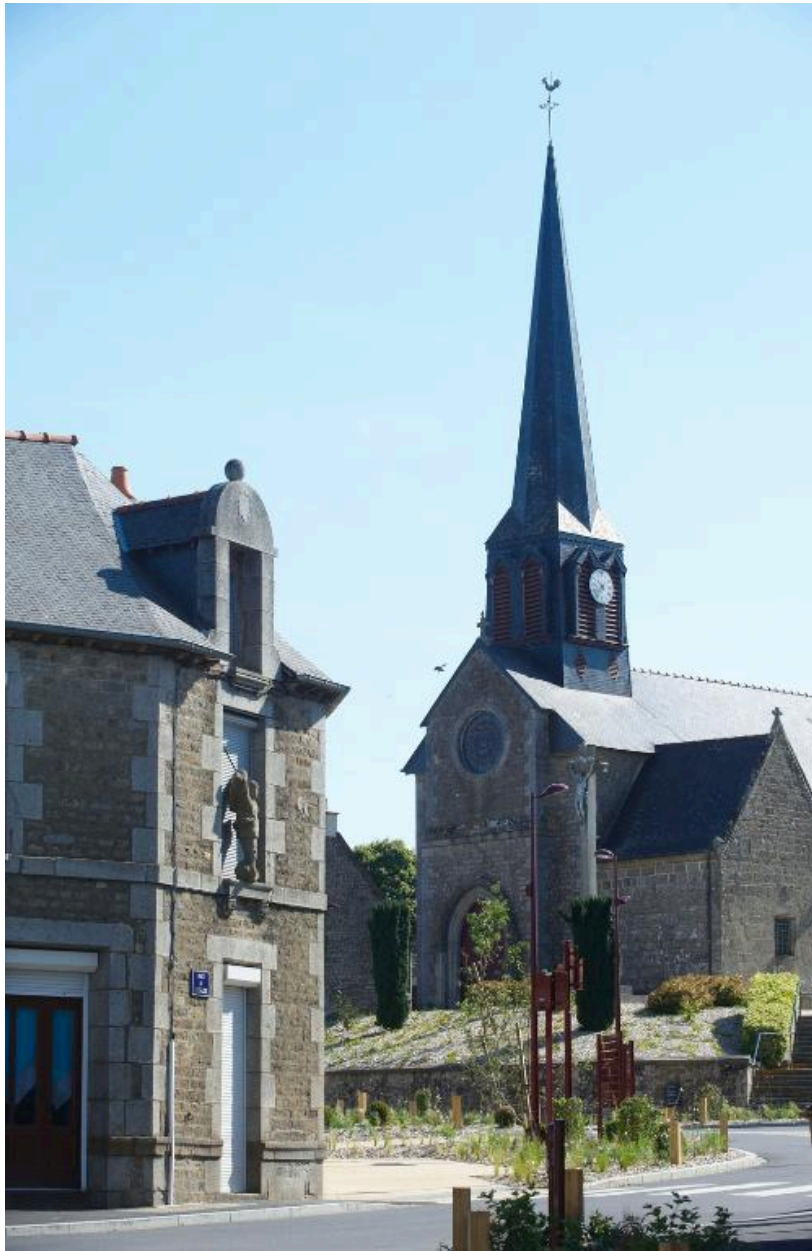
Elévation Ouest : vue générale du sud-ouest
