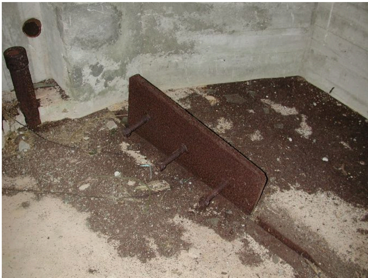
Vue d'un des deux éléments des flèches d'affût du canon (état en 2002). A gauche, tuyau de l'arrivée électrique
