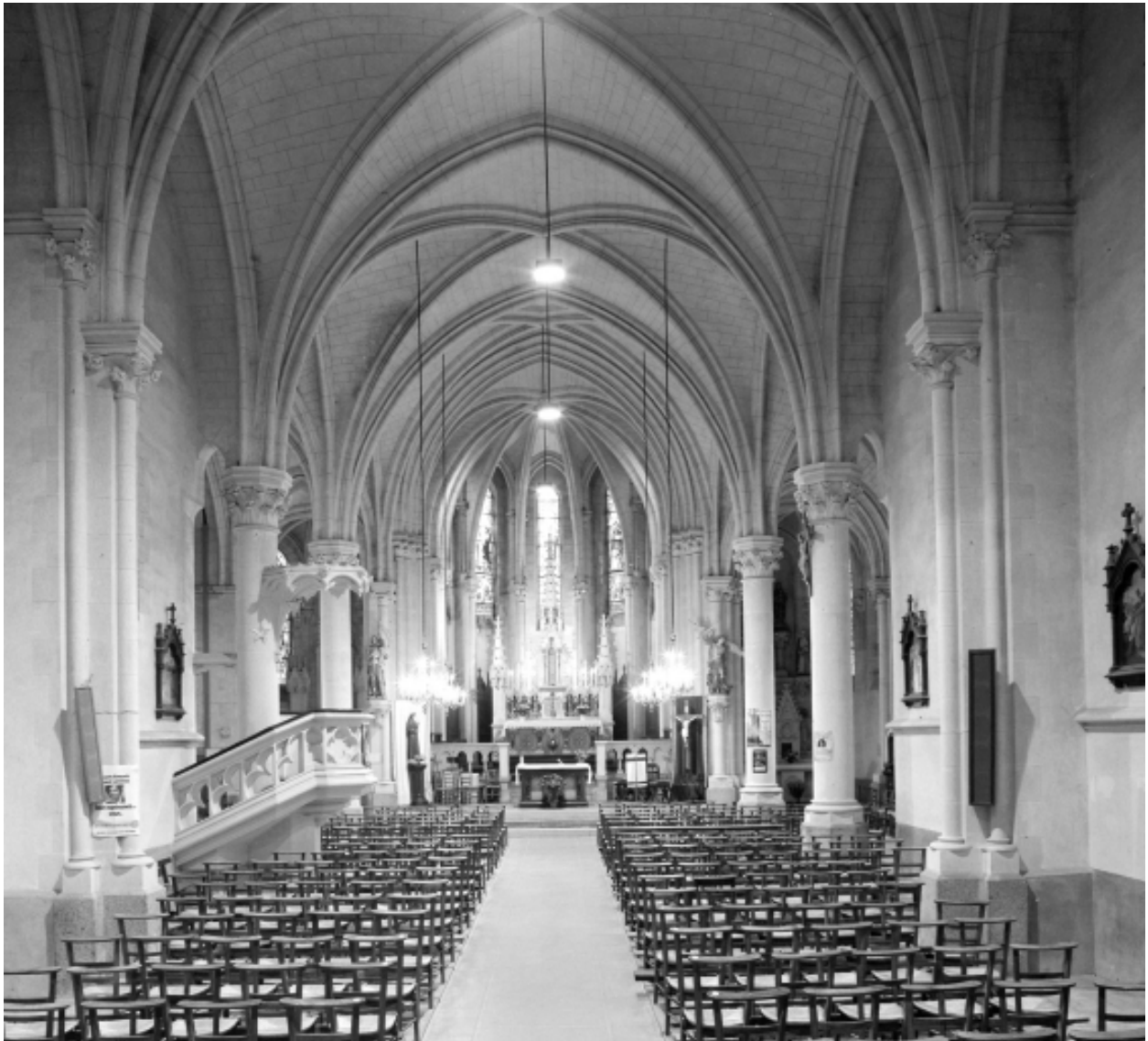
Intérieur : vue générale vers le chœur.
