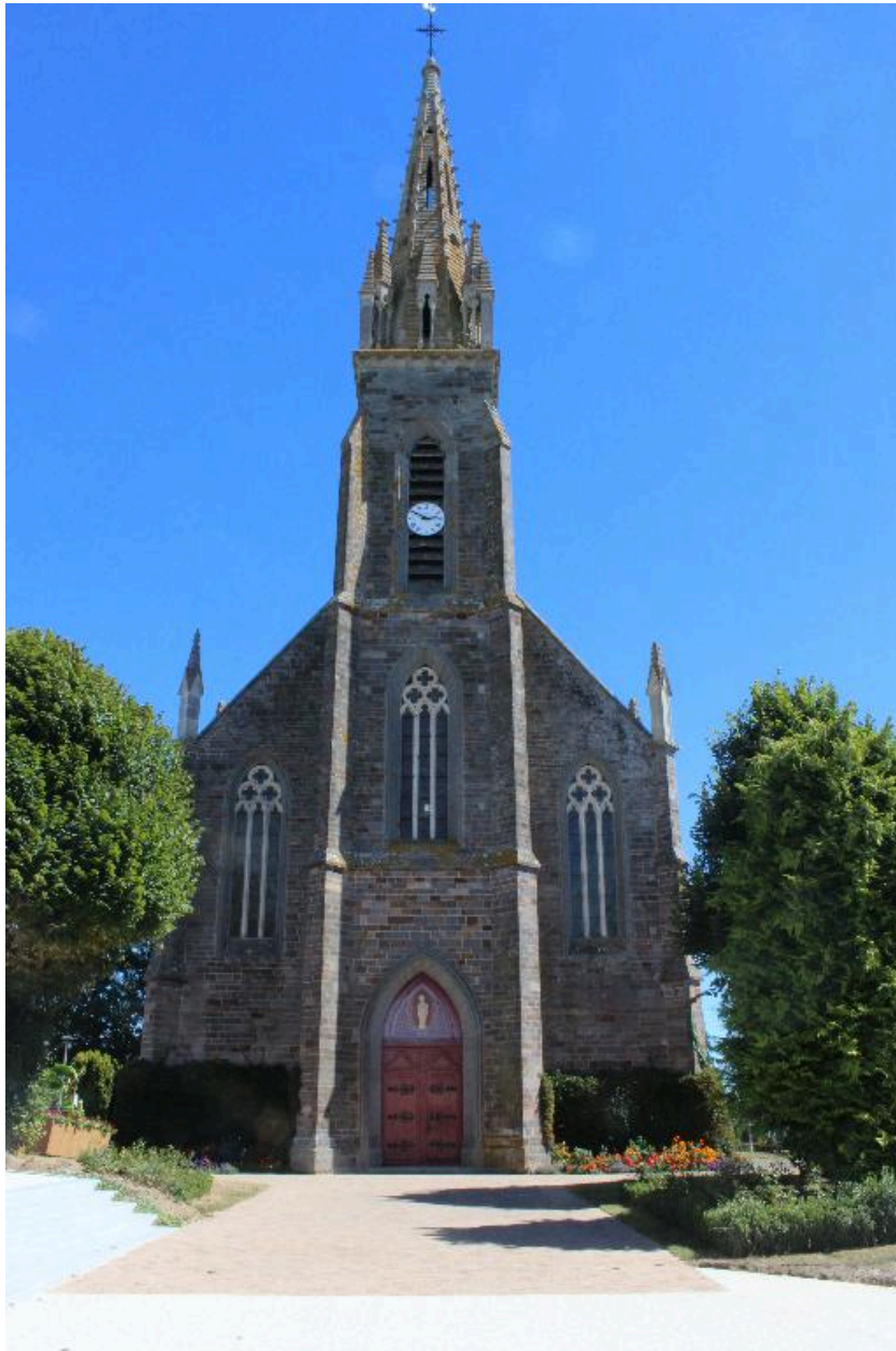
Façade principale : vue générale
