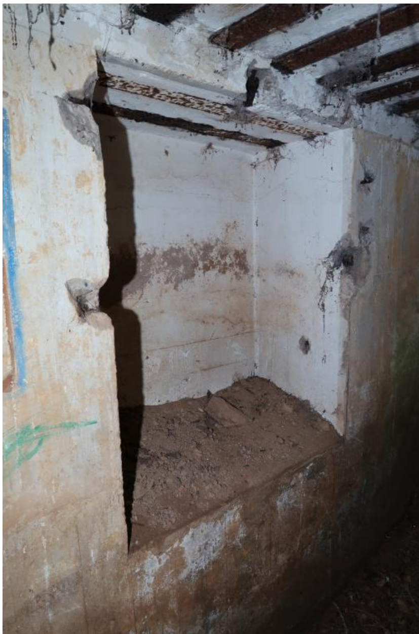
Vue de l'une des deux niches murales du couloir d'accès (état en 2021)
