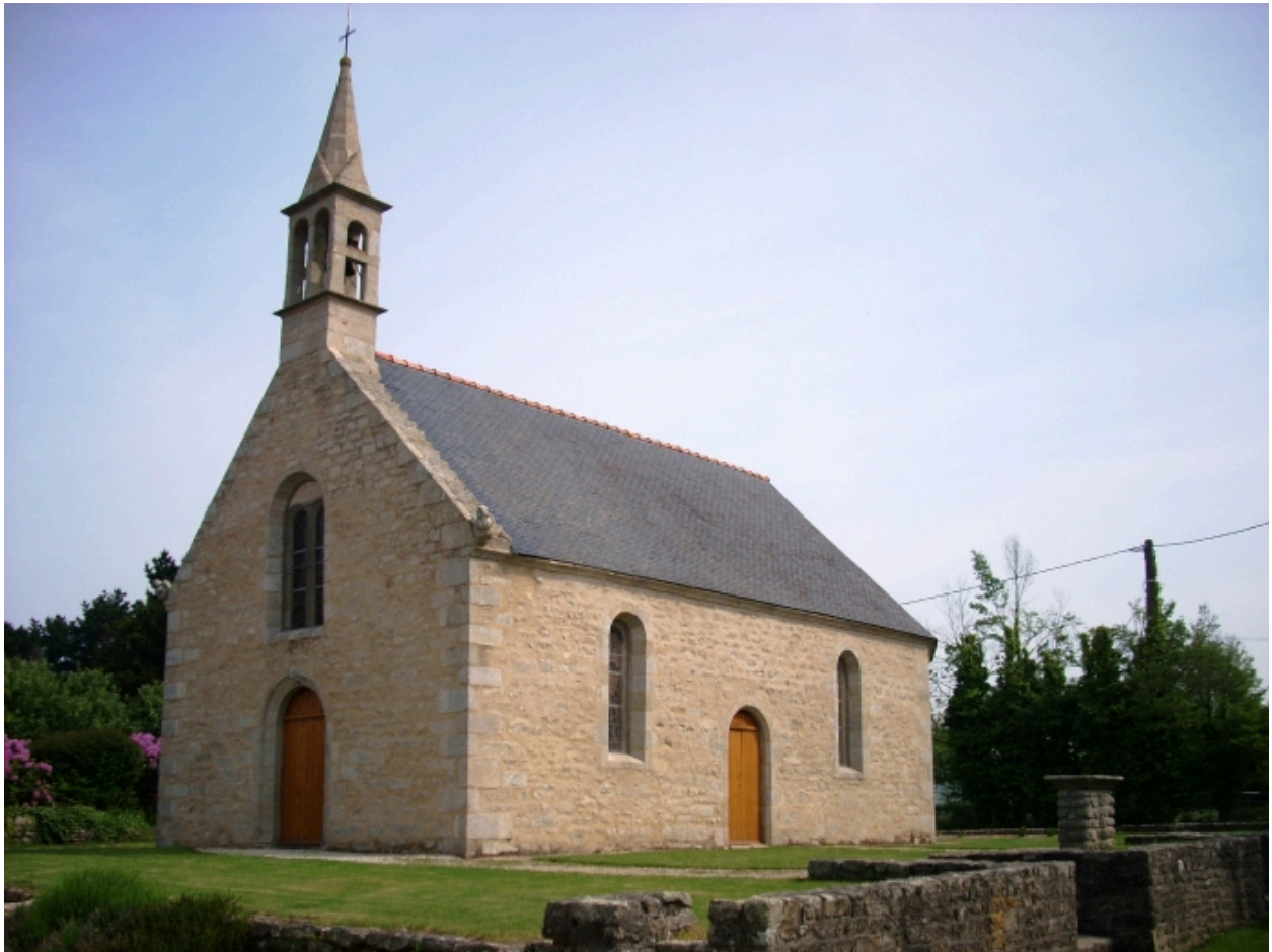
Plomeur, chapelle Saint-Côme et Saint-Damien : vue générale sud-ouest
