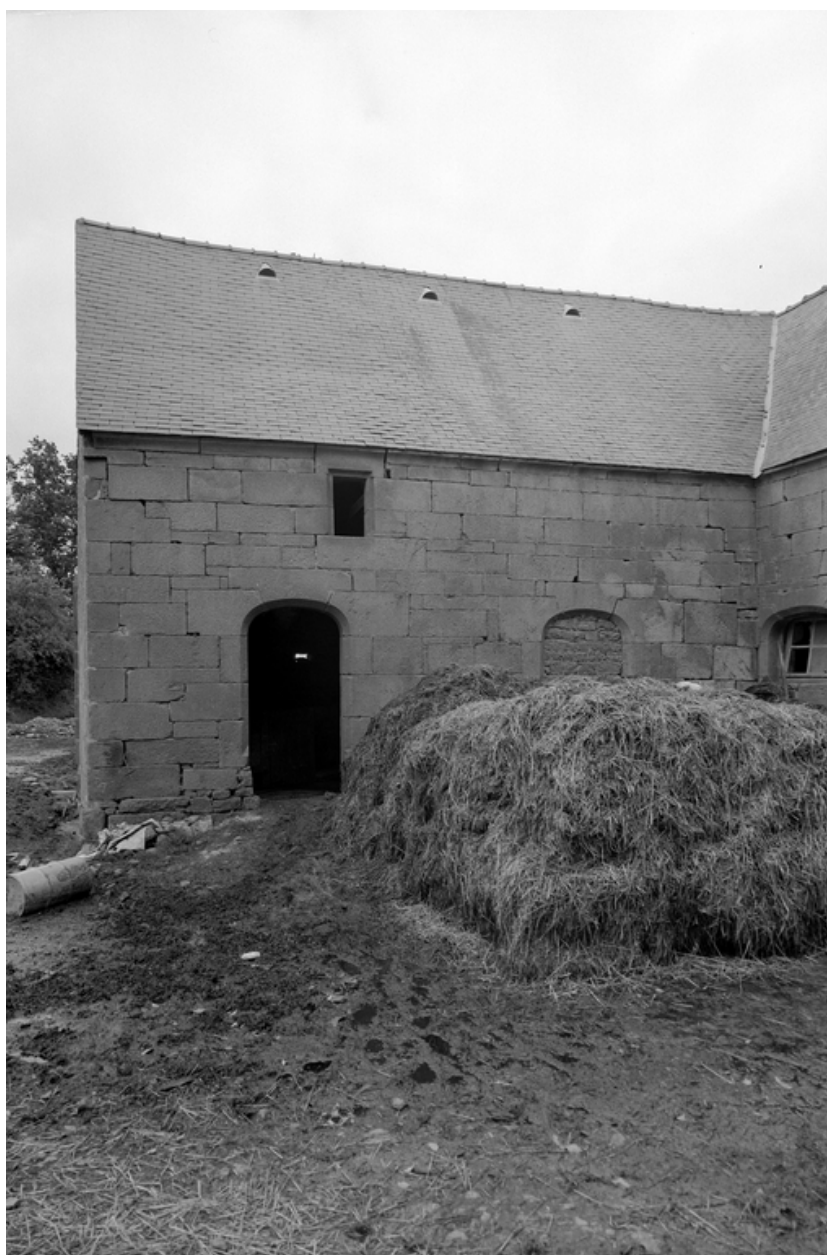
Bâtiment A, élévation nord
