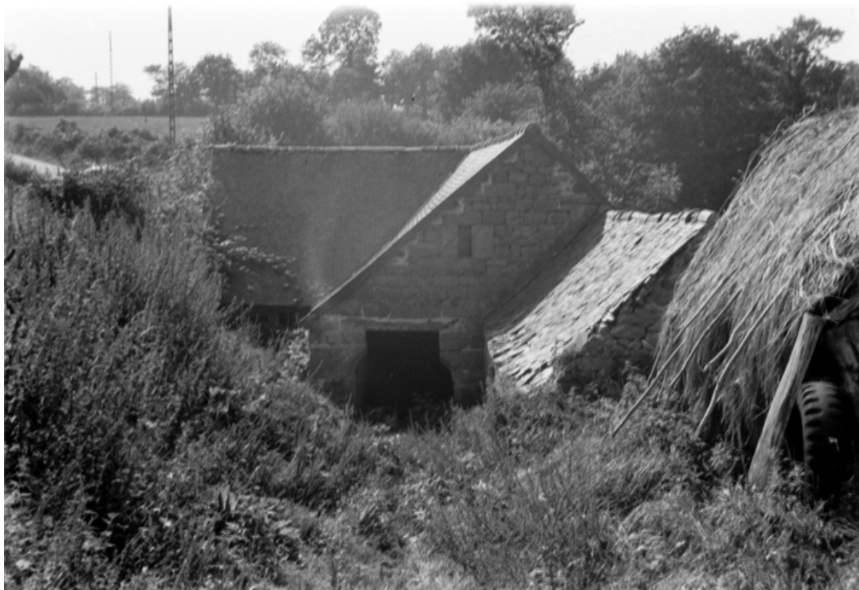
Vue de situation prise de l'est
