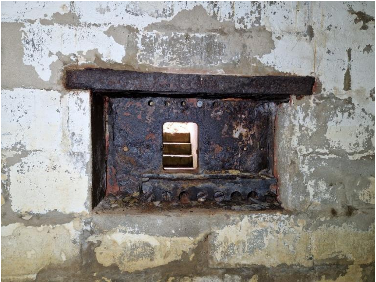
Vue intérieure : créneau blindé de la salle de garde est défendant l'entrée
