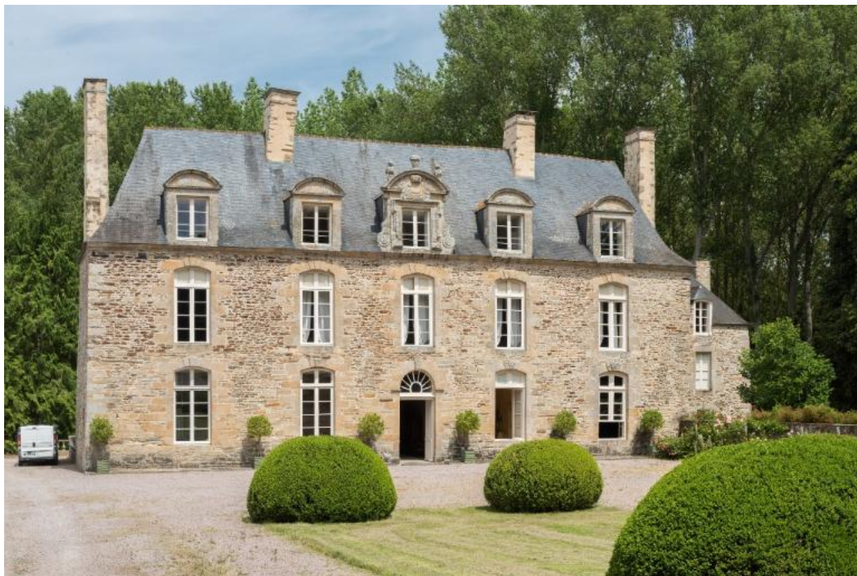
Vue d'ensemble, façade sud
