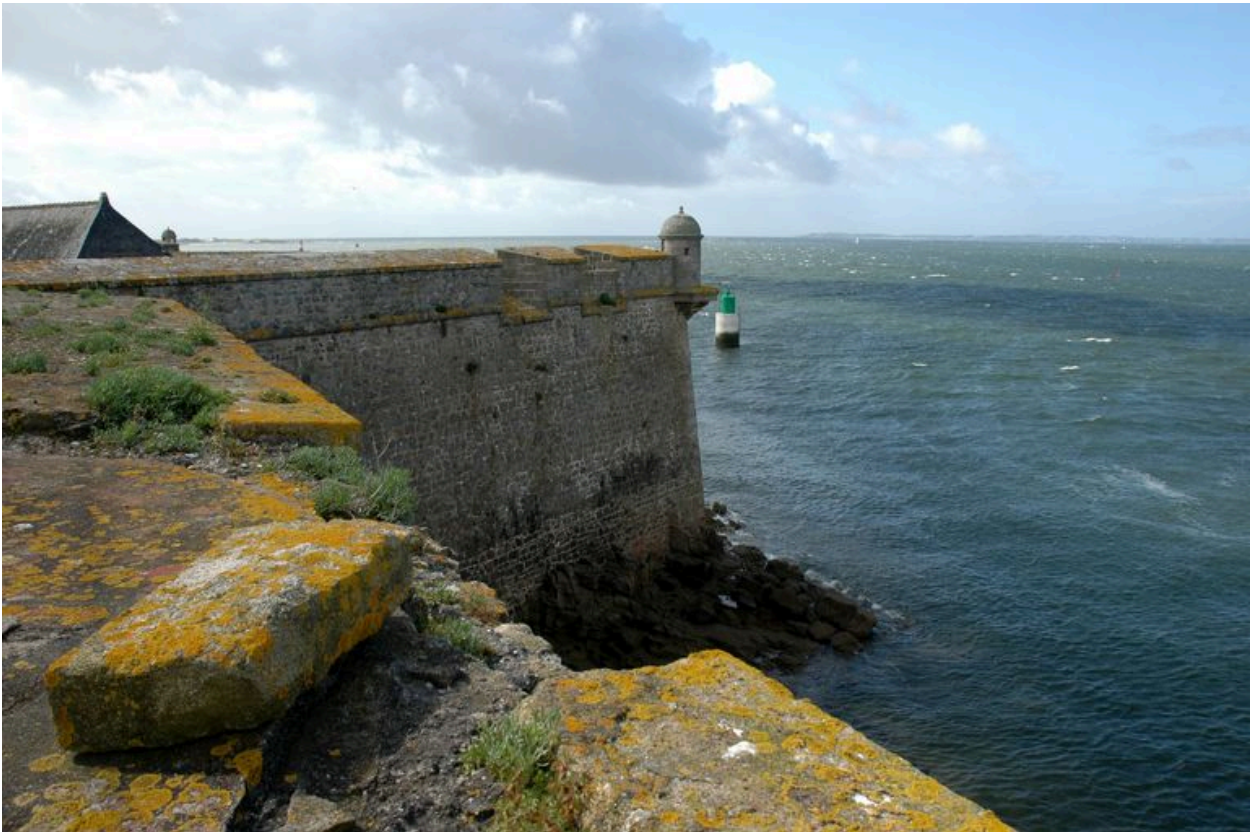
Vue de la citadelle de Port-Louis : embrasures plongeantes et échauguette du bastion dit l'Irrégulier
