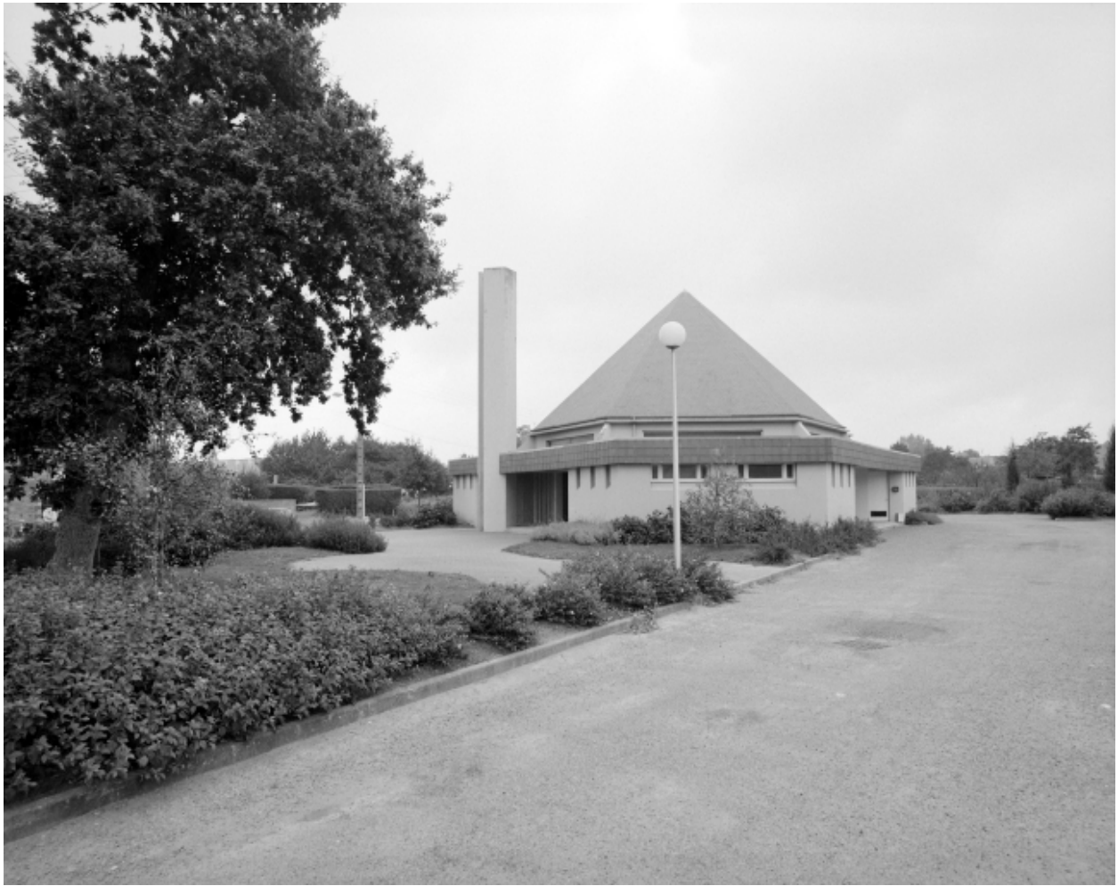
Elévation Est : vue générale
