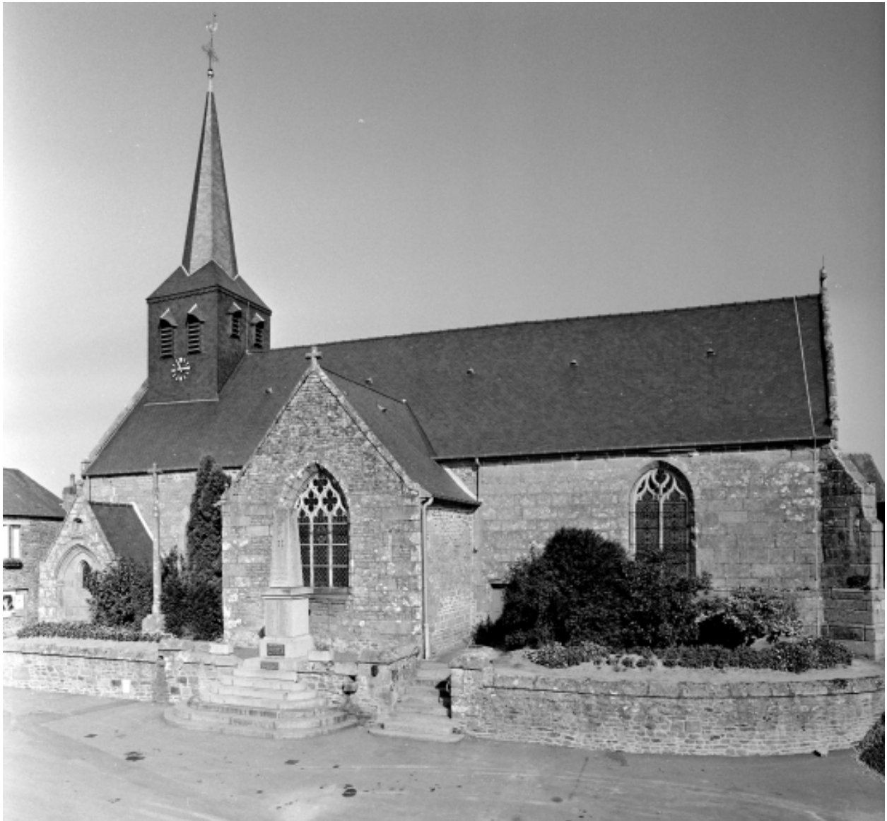
Elévation Sud : vue générale
