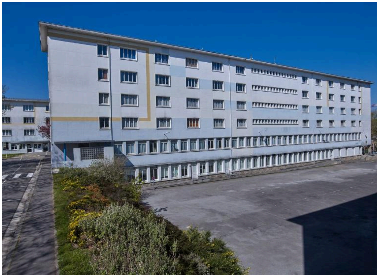
Bâtiment K, internat : vue d'ensemble de la façade est. J-B. Mathon, architecte.
