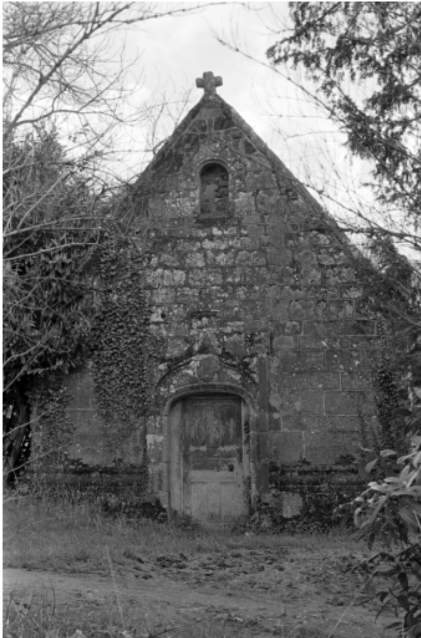
Chapelle : Façade nord
