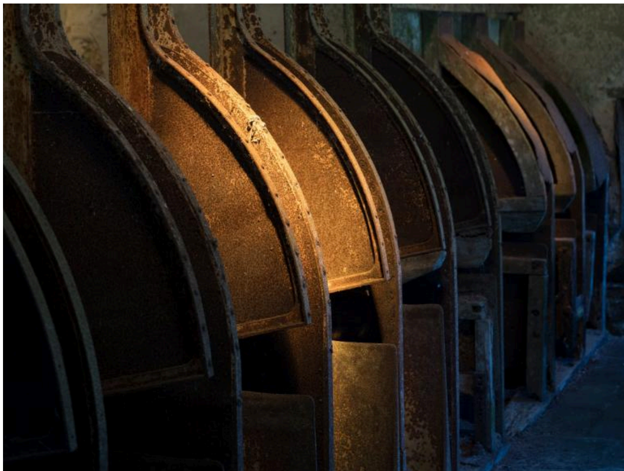
Bâtiment principal. Salle 3. Postes à espader. Détail
