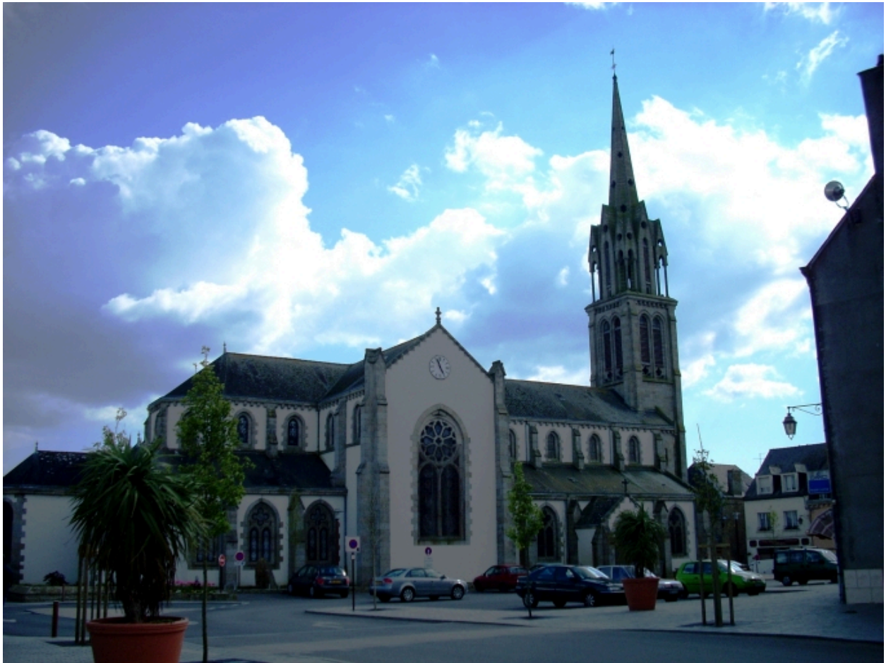
Moëlan-sur-Mer, église paroissiale Saint-Melaine : vue générale nord-est
