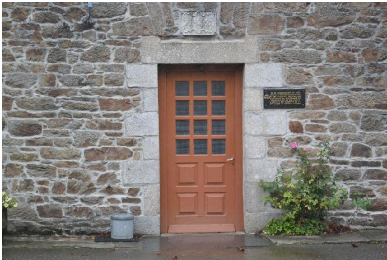
Maison d'habitation, 1852. Façade sud. Porte d'entrée surmontée de la date de construction
