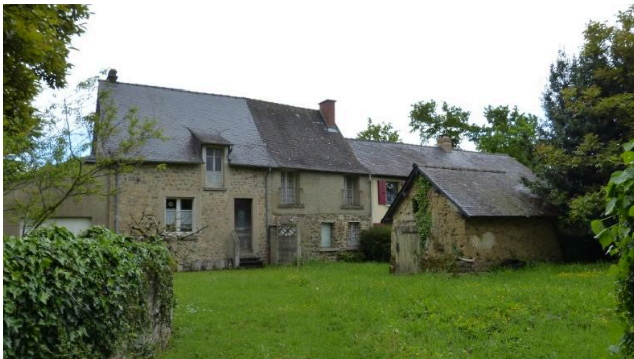
Vue générale, Montdidier (Hédé-Bazouges)
