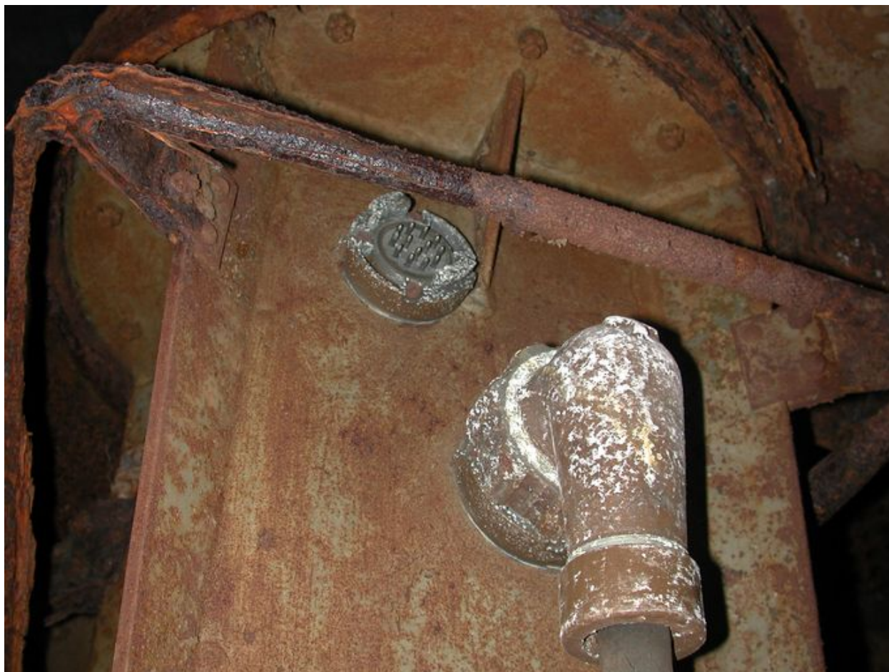
Vue intérieure : cloche blindée (état en 2003)
