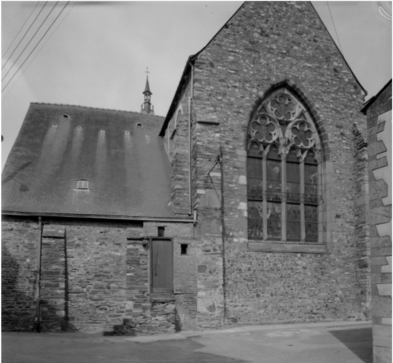
Elévation est, chevet : vue générale
