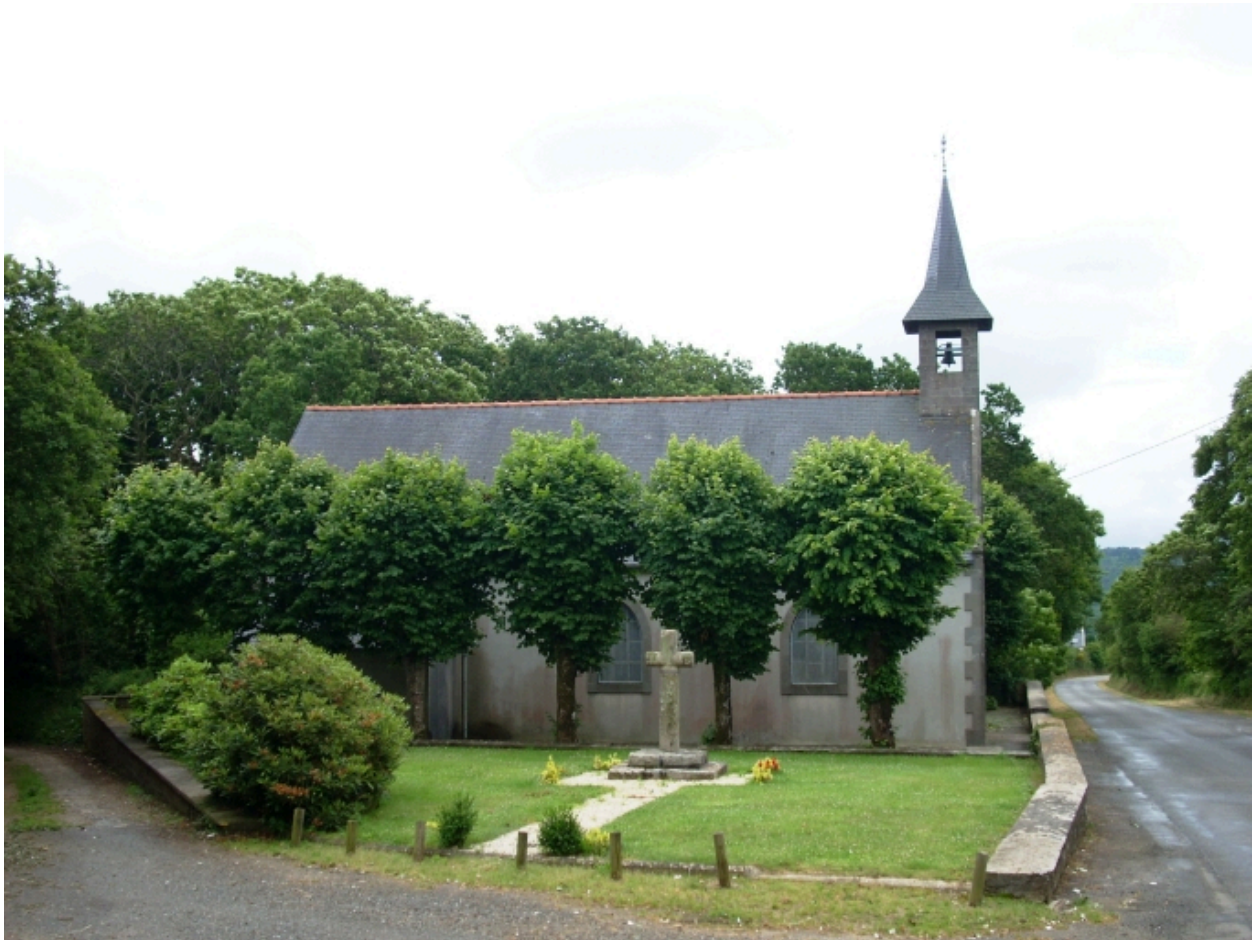
Guipavas, chapelle Saint-Yves : vue générale nord
