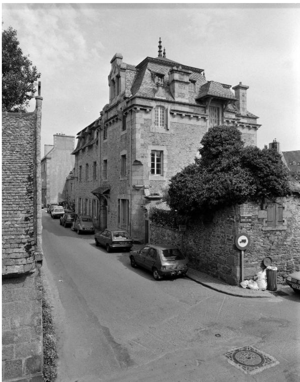
4 rue Pasteur, élévation nord et ouest, vue générale
