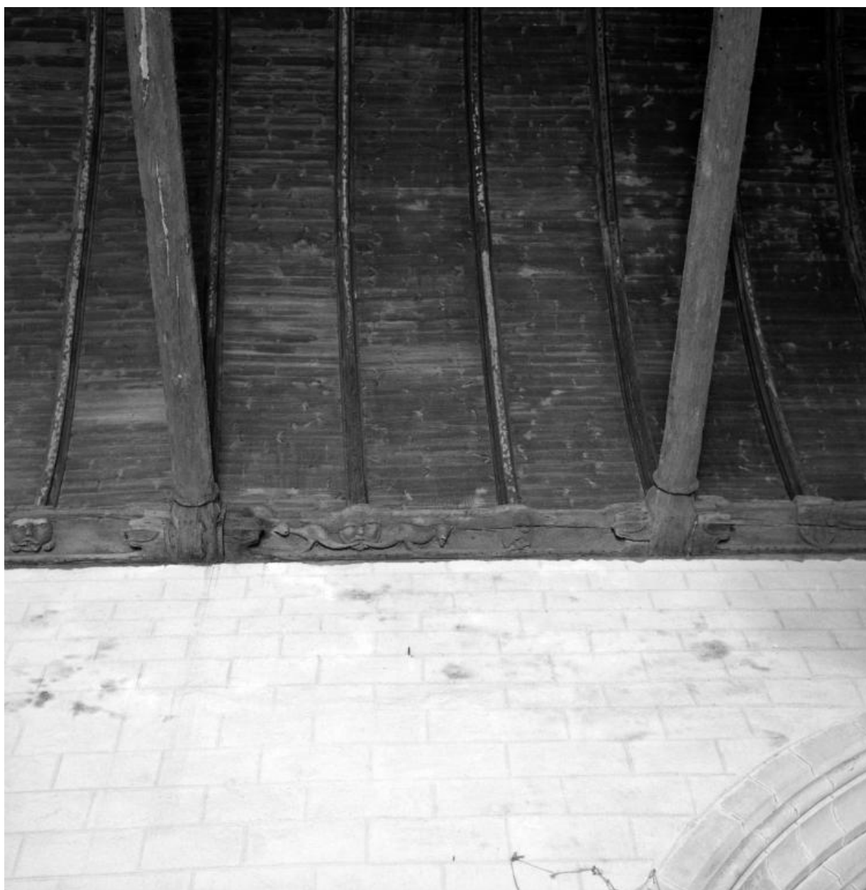
Sablères, détail du mur nord de la nef, entre entrails 3 et 4.
