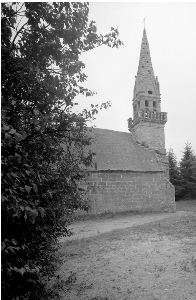
Nef et tour du clocher : élévation nord
