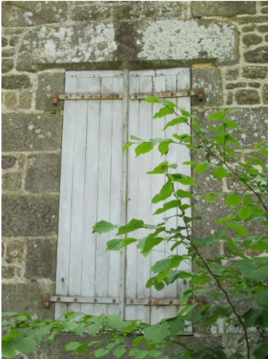
Fenêtre, façade postérieure
