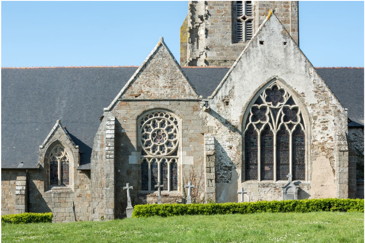
Succession de pignons et réseaux du XIVe-XVe siècles sur la façade méridionale
