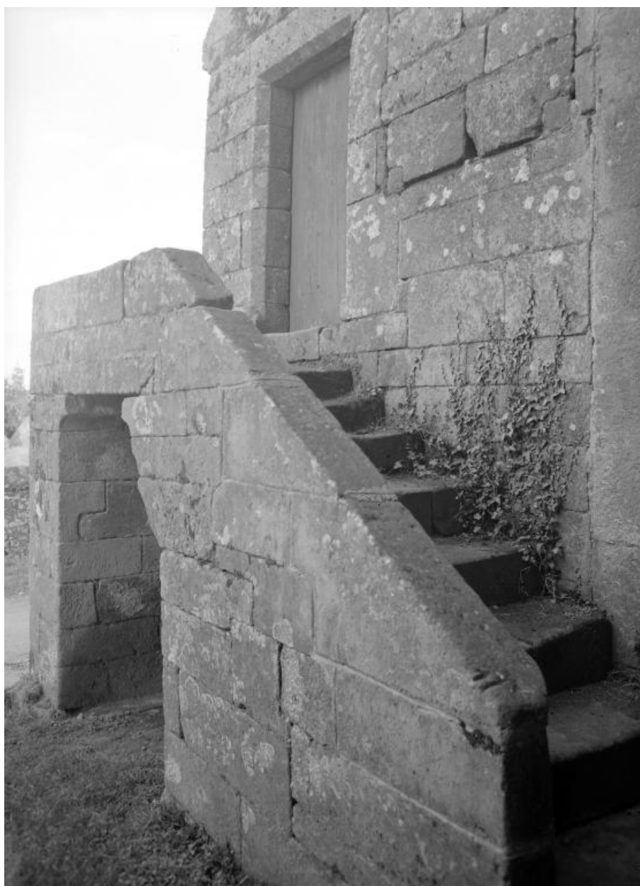
Escalier de l'extrémité nord ouest de la nef.
