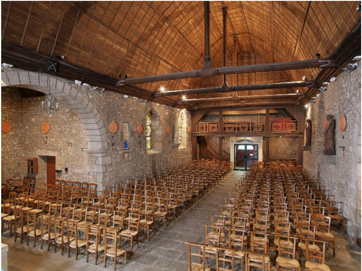
Vue intérieure vers la porte principale
