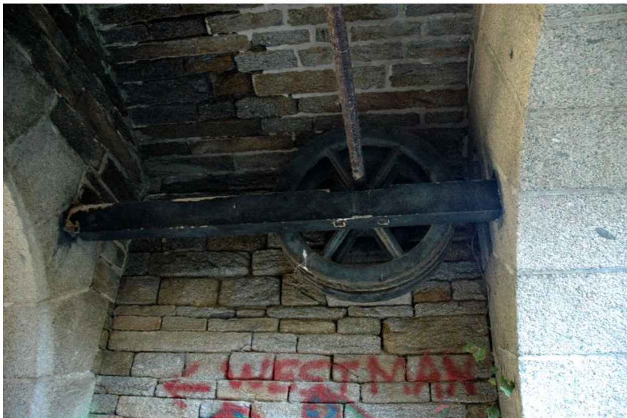
Vue du passage d'entrée : vestiges du pont-levis à contrepoids (état en 2006)
