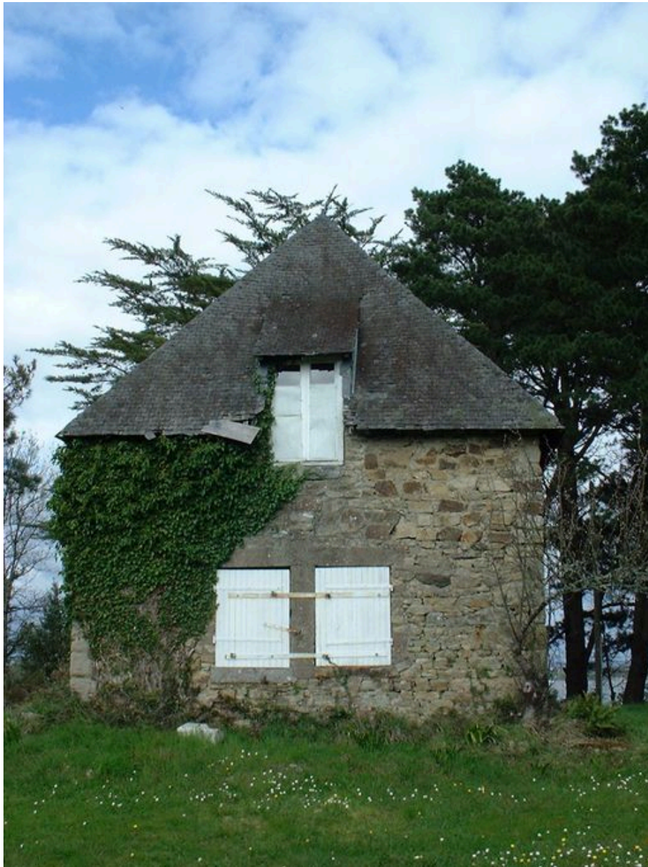
Guérite des douaniers de Barrarac'h
