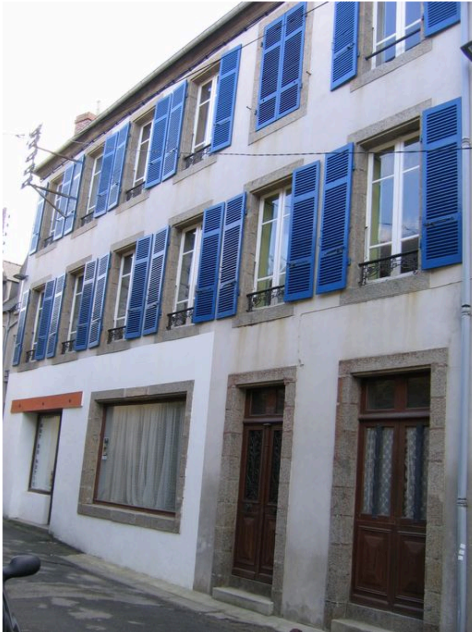
Maison n° 21, maison d'armateur et quincailler
