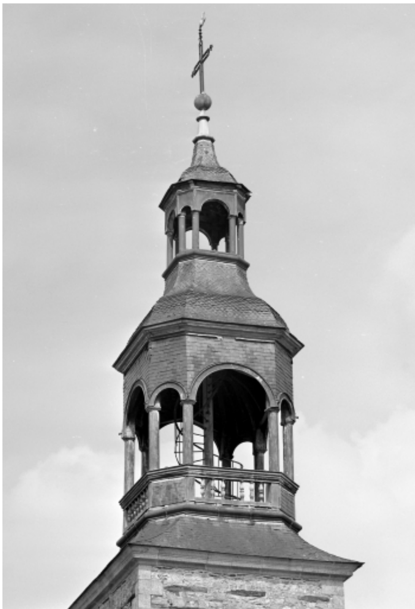
Vue générale du clocher.
