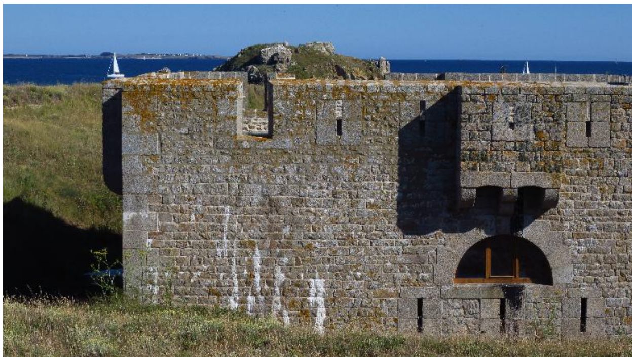
Île-d'Houat, batterie d'En Tal, corps de garde crénelé, détail de la façade nord-ouest.
