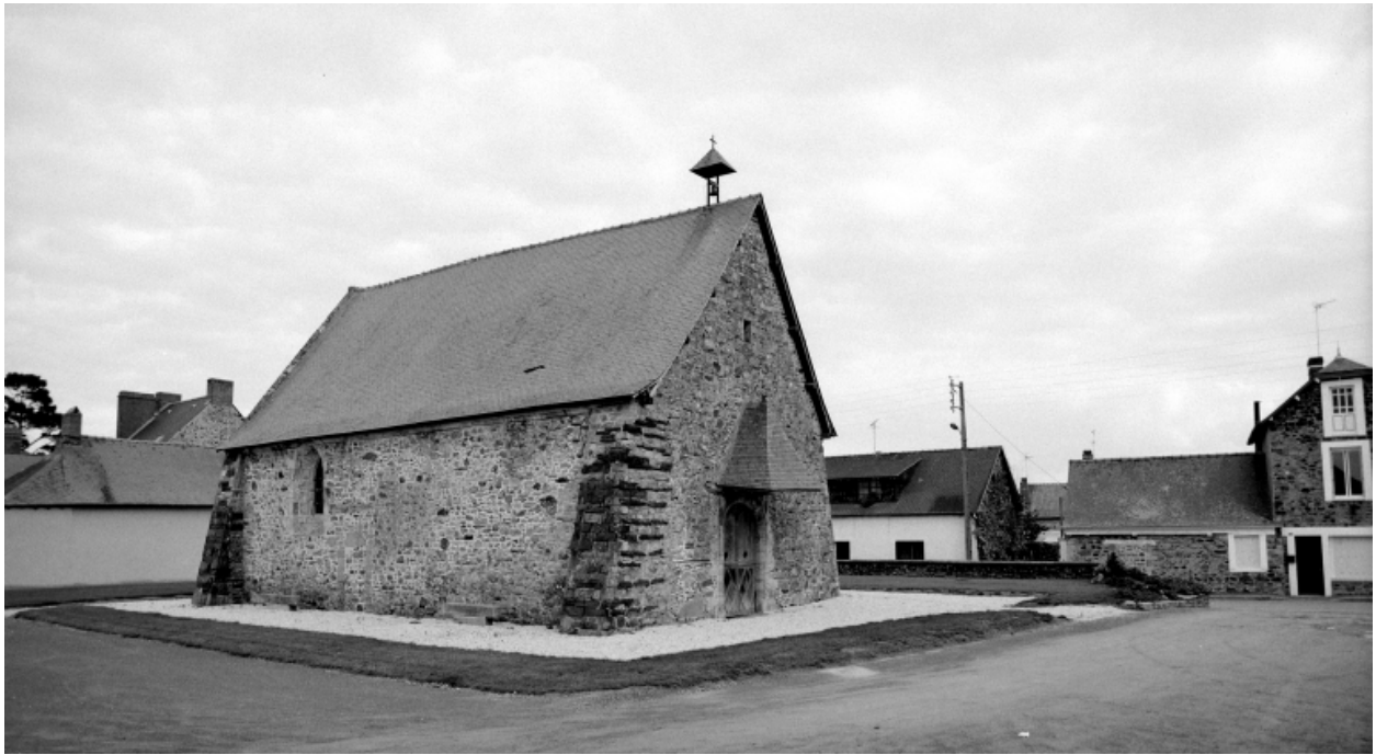
Elévation Nord-Ouest : vue générale
