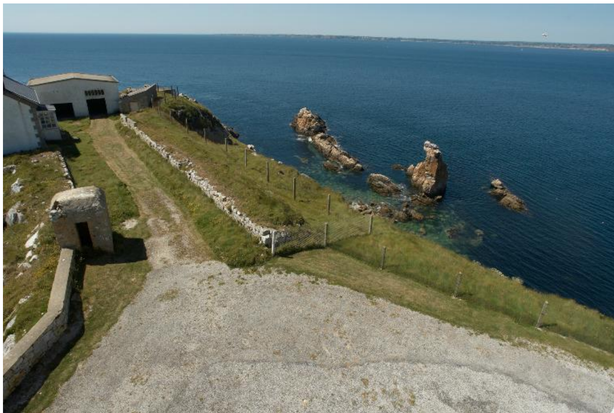
Camaret, pointe du Toulinguet : installations du phare
