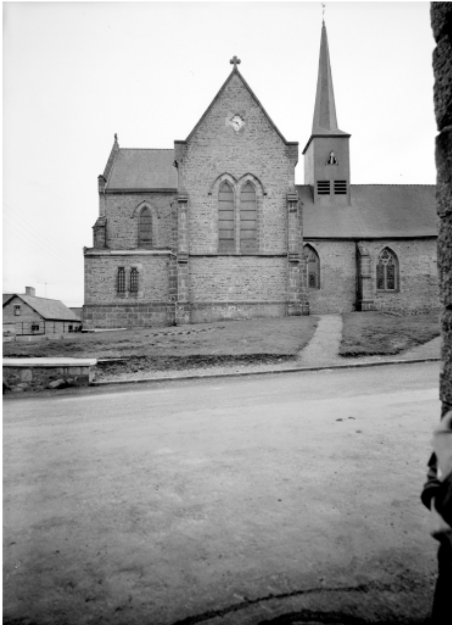
Elévation Nord, partie Est : vue générale
