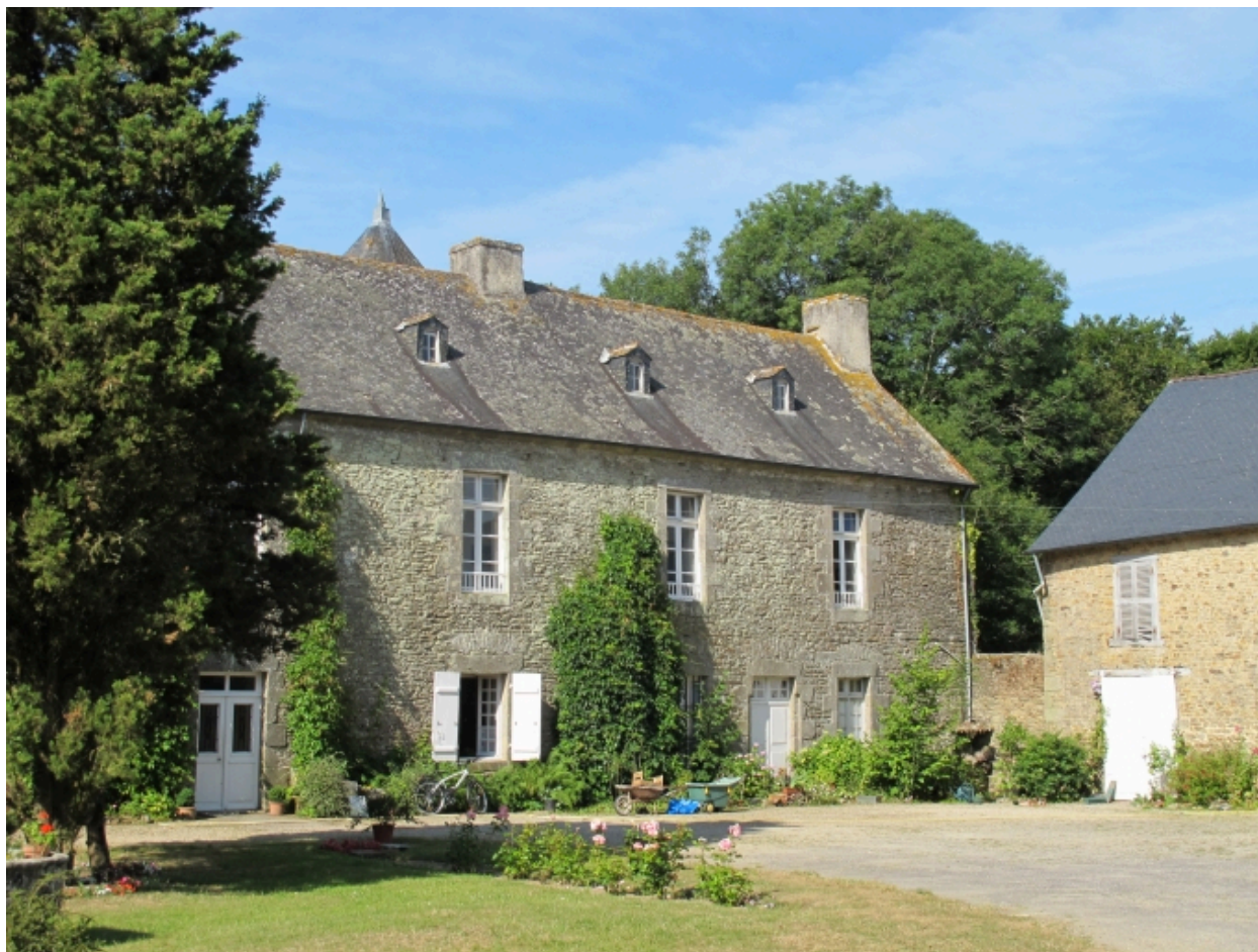
Logis, élévation nord, partie ouest
