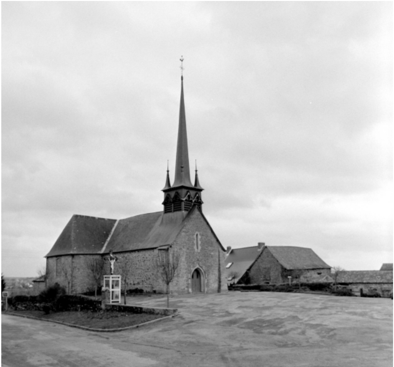
Élévation nord-ouest : vue générale
