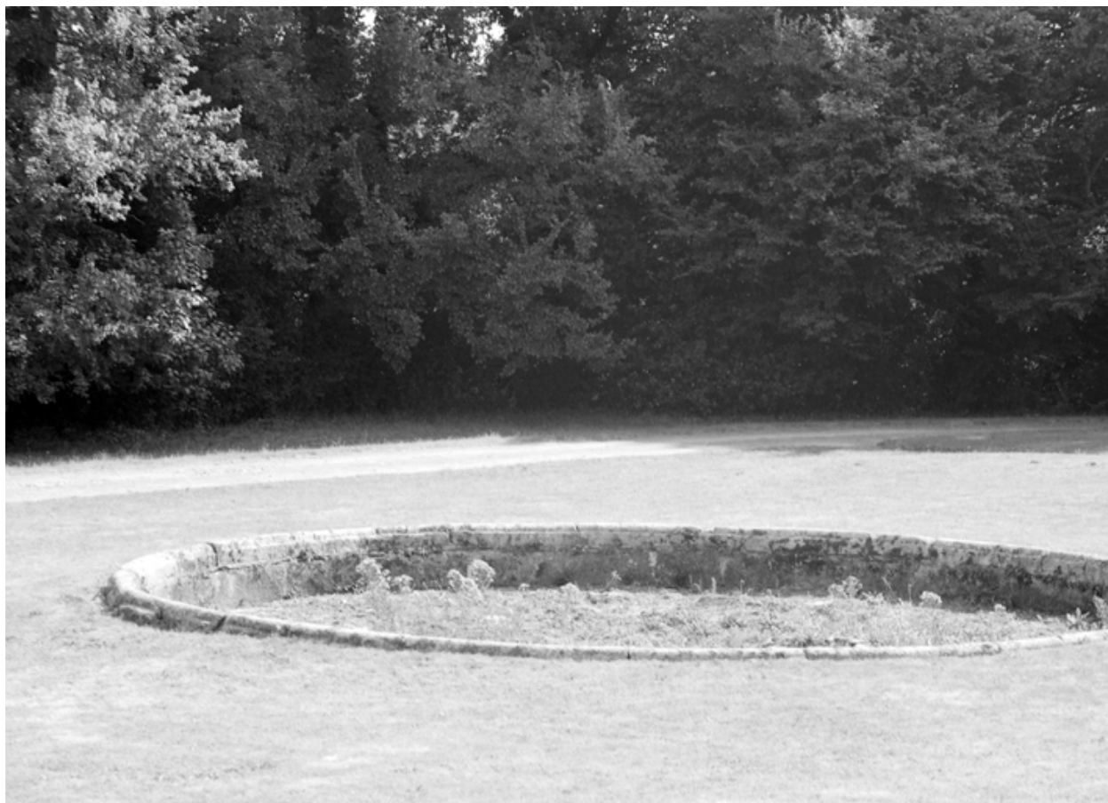
Bassin : vue générale (état en 1984)
