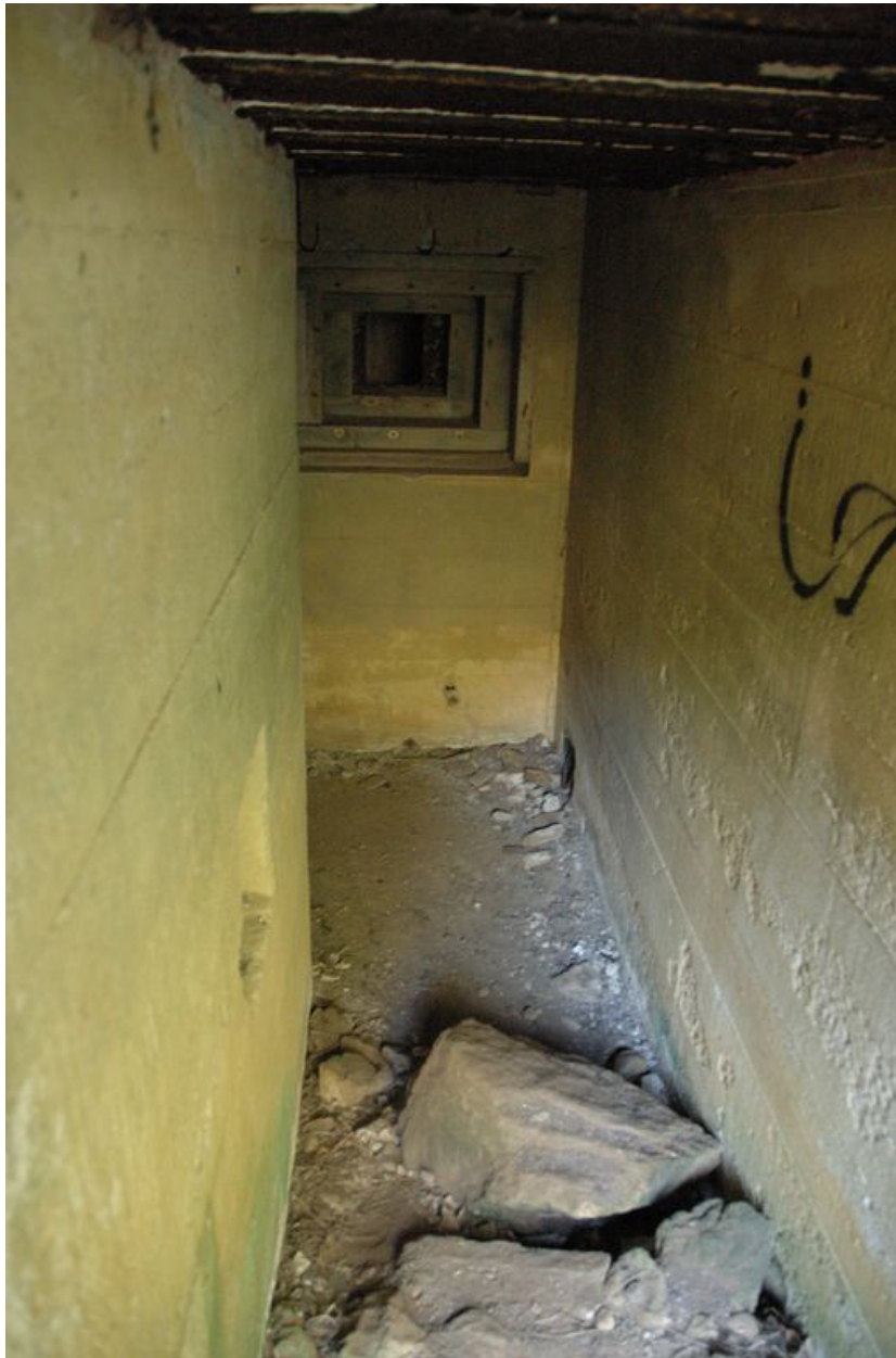
Vue de l'ensemble fortifié d'Illien (Stützpunkt Kerlouchouan) (Re 38, 39, Re 99-103, Re 124) : casemate de type 505 pour canon anti-chars
