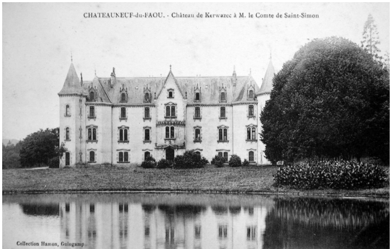
Vue générale de la façade antérieure (Archives départementales d'Ille-et-Vilaine, 6 Fi Saint-Goazec)
