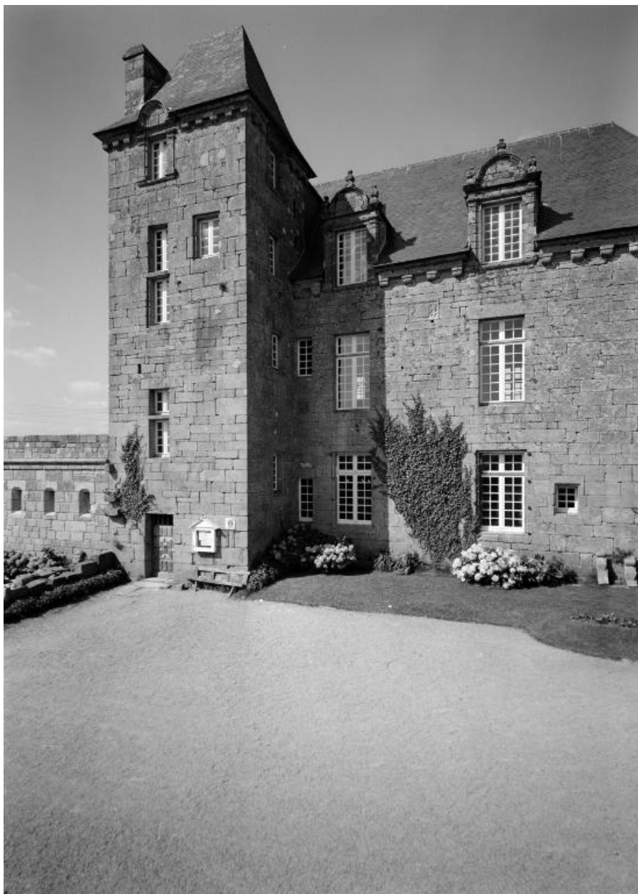
Vue d'ensemble façade sud et partie ouest du bâtiment
