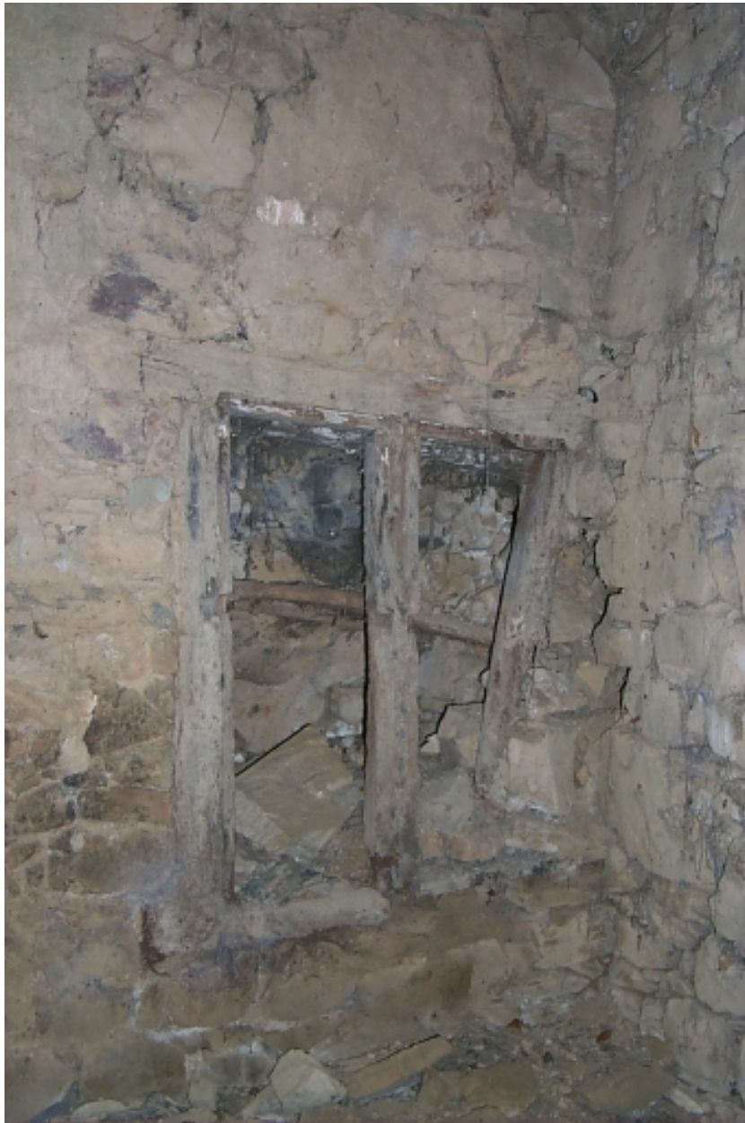
Intérieur, mur sud du chœur, armoire murale
