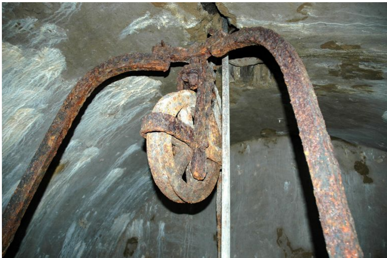
Vue du fort de Penfeld : détail de la poulie du puits situé sous le passage d'entrée
