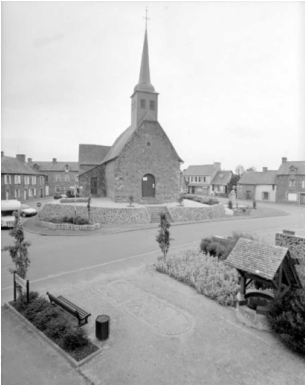
Elévation ouest : vue générale
