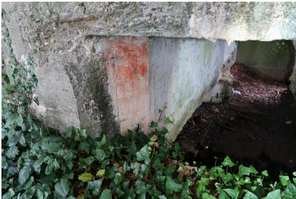
Vue de détail de l'embrasure (état en 2021)
